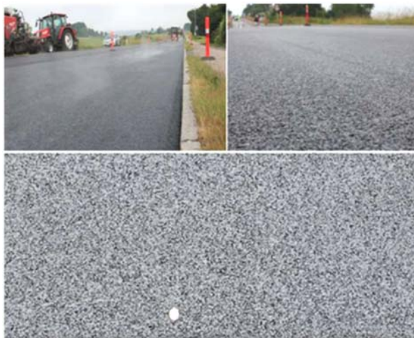
Fig. 3. Vrazhdësia e asfaltit dhe korrelacioni me fërkimin
